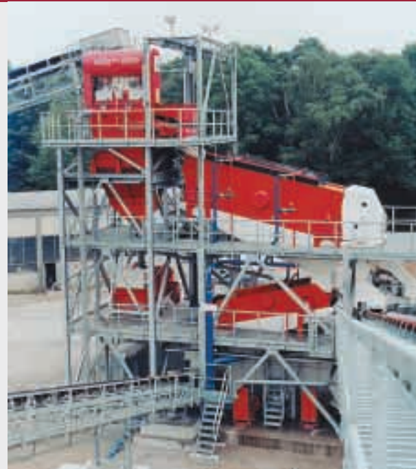
Abb. 5 | Kiesaufbereitung und Körnungssilos, Kieswerk Forchheim, Fa. Karl Eppe
