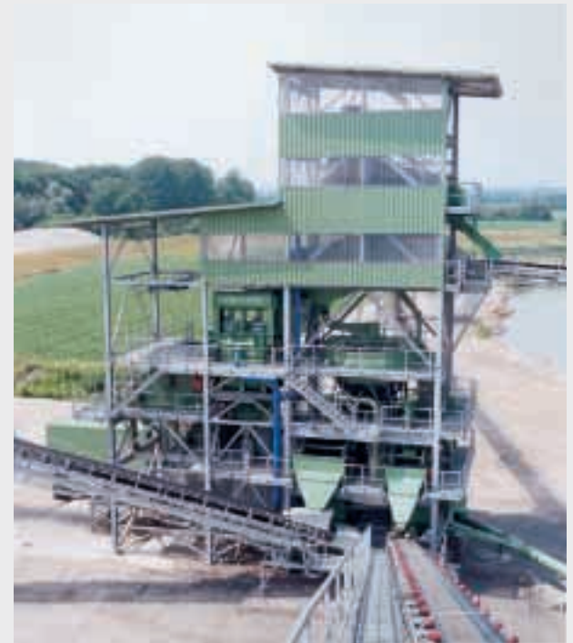
Abb. 7 | Aufbereitungsanlage Kieswerk Hagenbach, Fa. Silex Normkies
