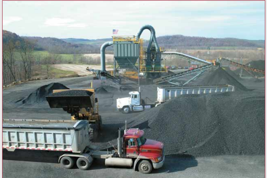
Abbildung_01: Aufbereitungsanlage mit allair® -Luftsetzmaschine bei der Fa. Holmes Limestone Company im Staat Ohio | USA
